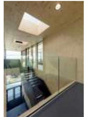
Für die Wand- und Deckenkonstruktion des von WRK Architekten entworfenen Gebäudes wurden 350 und 230 mm hohe Kerto-Ripa-Box-Elemente verwendet. Foto: Metsä Group
