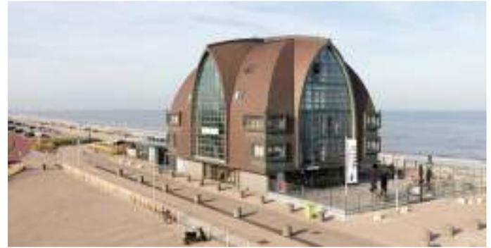
Hotel mit Metaldach und Fassade direkt an der windigen Nordsee: Hinter den Kupferschaaren sorgen puren MetalFix-Dämmelemente für Wärmeschutz. Bild: puren
