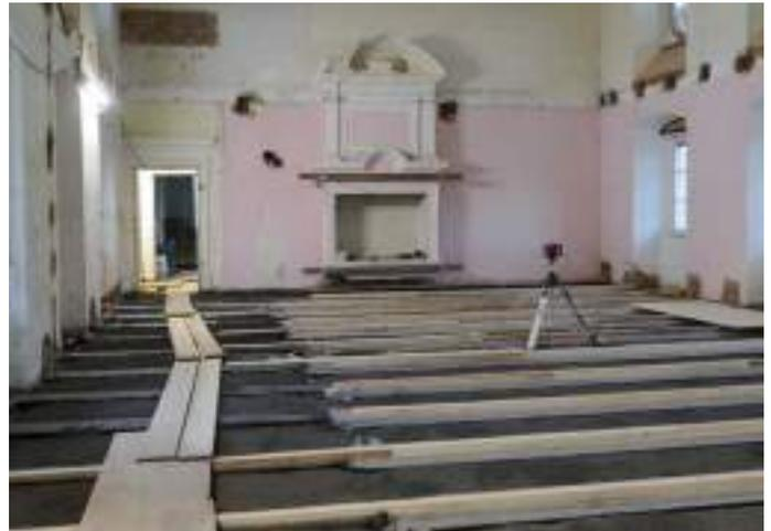
Für die Verfüllung der Holzbalkendecken im Großen Festsaal war Liapor-Blähton der passende Baustoff: feuchteregulierend, reversibel, dämmend und leicht einzubringen. Foto: Büro Bergmann GmbH
