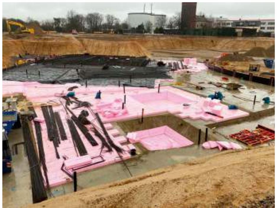
Da die Bodenplatte später als ein Bauteil bewertet wird, musste eine durchgängige Dämmebene – inklusive aller Vertiefungen, wie hier der Aufzugsunterfahrten – erstellt werden.
