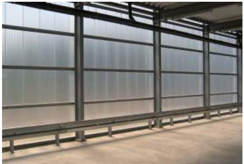
*Eine Fassade aus Polycarbonat lässt auf natürliche Weise Licht durch. Somit wird eine Innenbeleuchtung an vielen Stellen tagsüber komplett überflüssig.*
